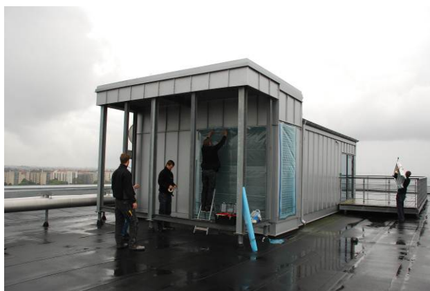
Bild 21: Kontor 3 – tätning av aggregat på taket inför täthetsprovningen.
