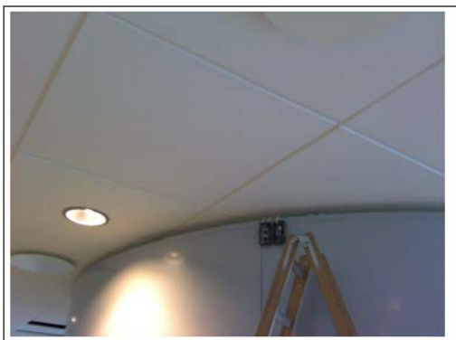
Bild 46: Luftläckage vid entrékarusell.
