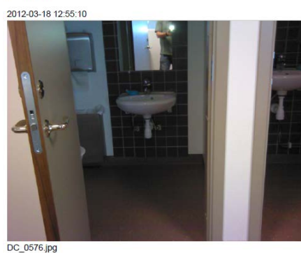
Bild 9: IR och digital bild av luftläckage genom vatten rör i rör system.
