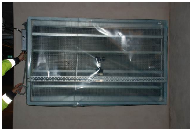
Bild 22: Kontor 3 – tätning av aggregat i källaren inför täthetsprovningen.
