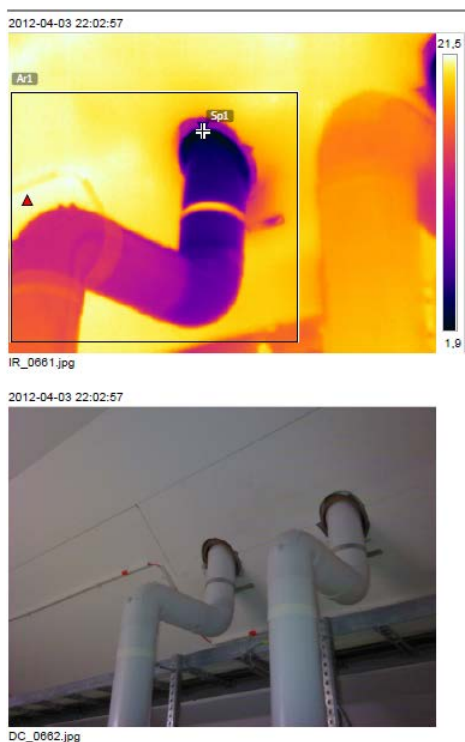
Bild 10: IR och digital bild av luftläckage vid en otät genomföring genom taket.
