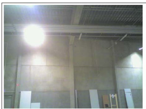
Bild 12: Luftläckage vid pelare.
