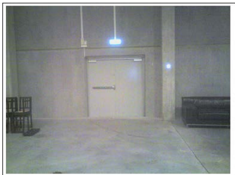
Bild 24: Luftläckage runt dörrar.
