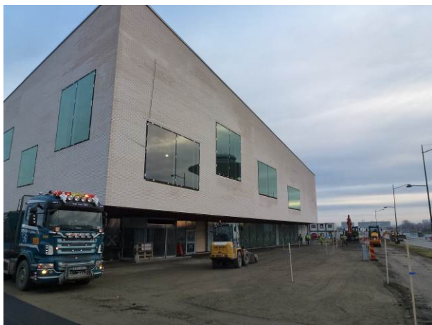
Bild 2: Entrésidan av kontor 1.
