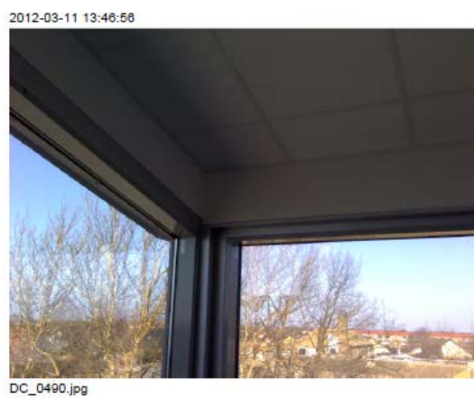
Bild 6: IR och digital bild av läckage mellan fönster partiet är väggen.
