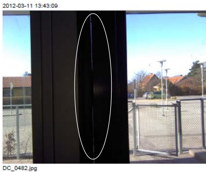
Bild 7: Glapp mellan gummi i en ytterdörr.
